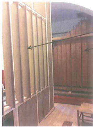
Svelledøre under montering
