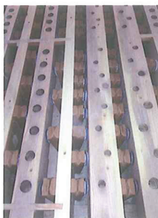
Fundament rengøres/afslibes. Defekte tasker udskiftes.
