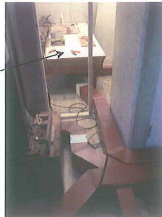
Sv. under opbygning
