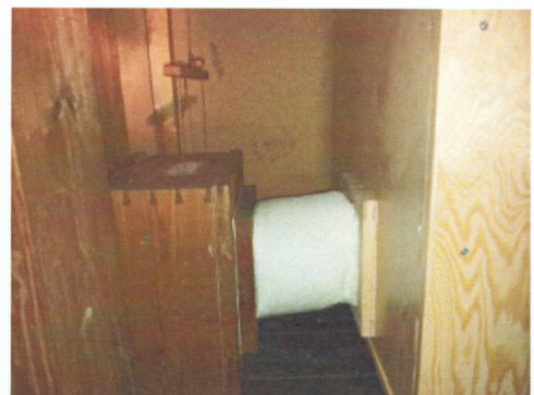
Rulleventil og skindforbindelse til blæser.
