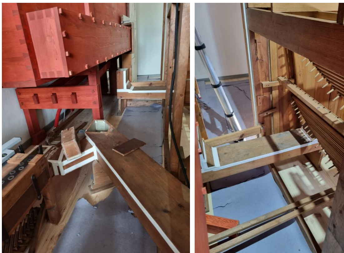
Istandsættelse af orglets vindkanaler
