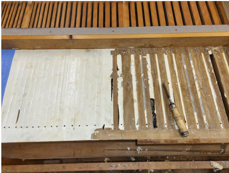
Manualvindlade, afrensning af gammel skindbelægning
