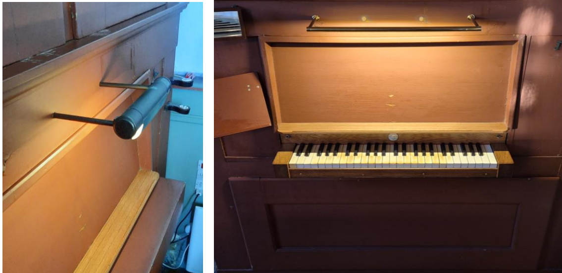
Gl. nodebelysning udskiftet til LED lyskilde, i messing armatur.
